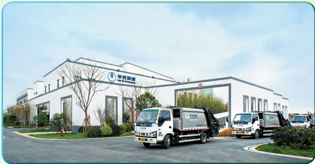
集团于苏州工业园区的厨余处理项目。
