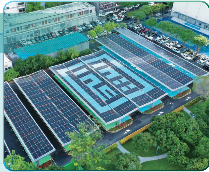
集團為深圳公共機構建造的虛擬電廠項目。
