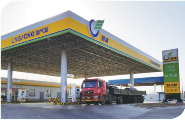
在内地的液化石油气加气站
