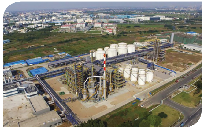
集团在江苏省张家港市兴建把非食用油脂原料提质为加氢精制植物油的厂房
